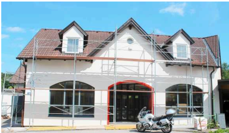
▲ Derzeit sind die Malerarbeiten im Außenbereich des Kaufhauses im Gang. Foto: Ernst Klement
